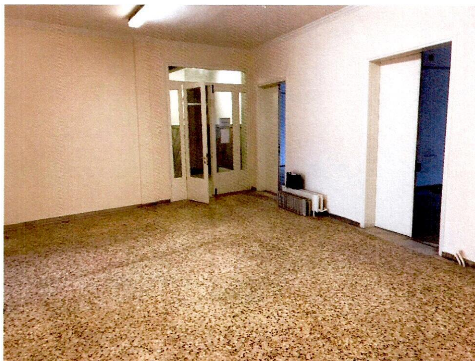
Εικόνα 6: εσωτερική άποψη γραφείων 3 ου ορόφου
